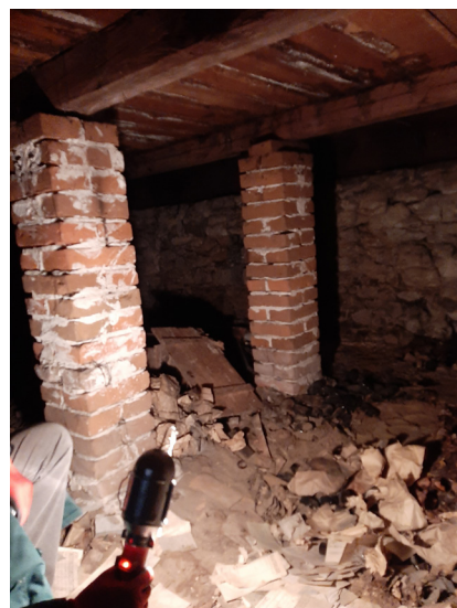
WNĘTRZE PIWNICY POD BUDYNKIEM PCK
