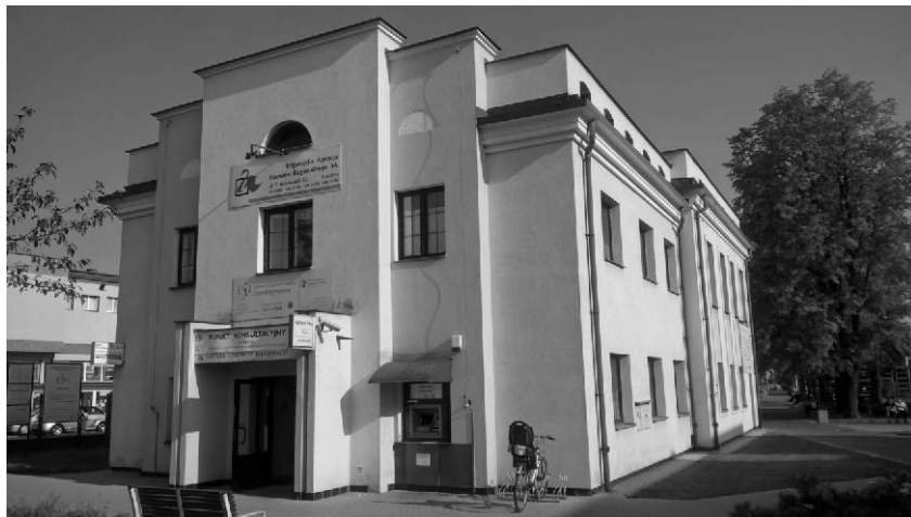
Stara elektrownia - BARR
