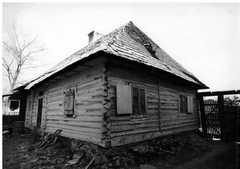
Zagroda 1972r. przed remontem
