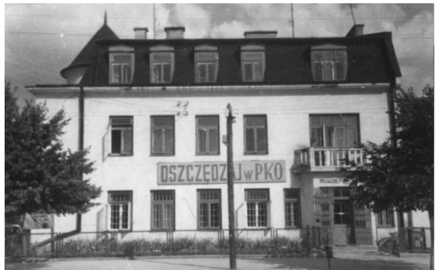
Kolejny budynek poczty biłgorajskiej przed przebudową w latach 70-tych ubiegłego wieku.
