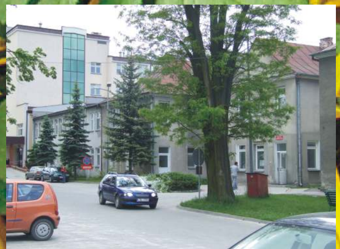
Etapy rozbudowy szpitala. Część najstarsza po prawej
