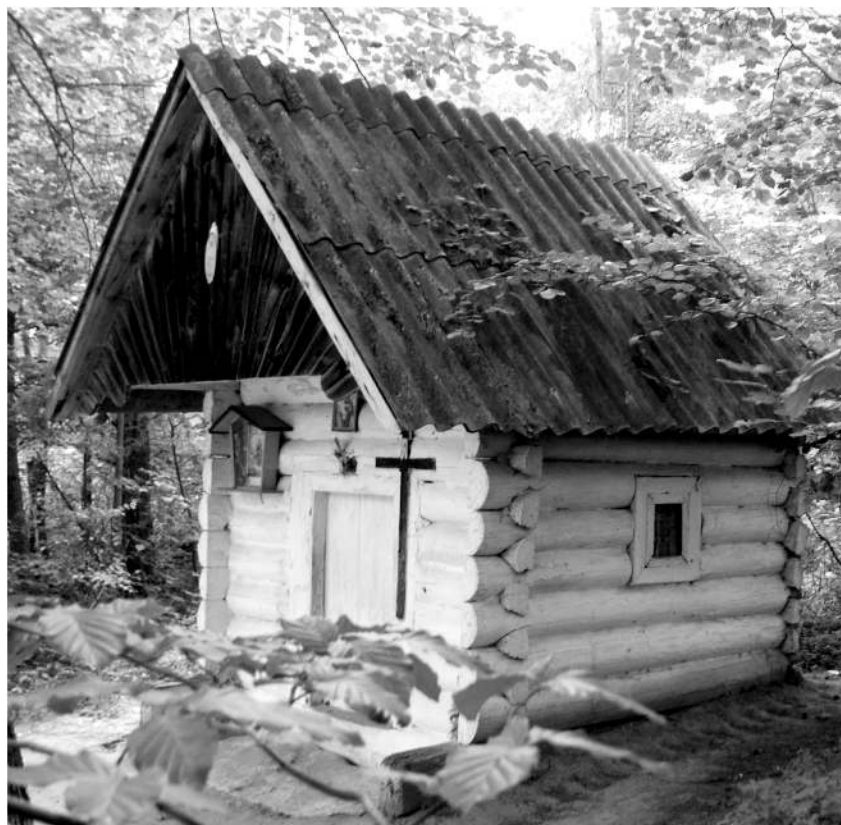
Kapliczka pw. Św. Antoniego w Trzęsinach. Początek XIX w.
